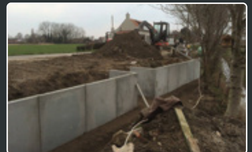
PLAATSEN VAN KEERMUREN
