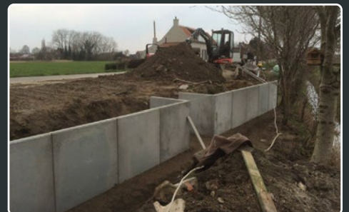
PLAATSEN VAN KEERMUREN
